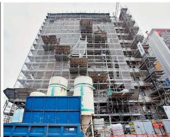
Il cantiere I lavori del nuovo hotel tra via Cesare de Lollis e via dei Dalmati
