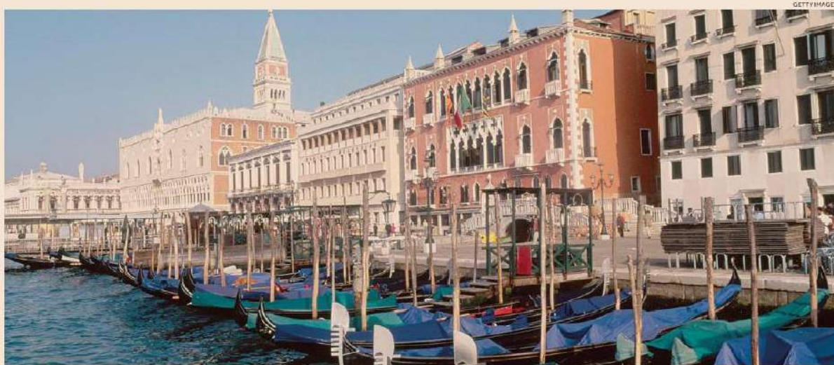
Venezia. L'edificio che ospita il Daniele, hotel che dal 2026 diventa parte della catena Four Seasons. A due passi da piazza San Marco l'albergo sarà oggetto di una profonda ristrutturazione
